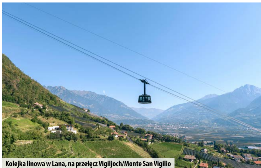
Kolejka linowa Olang 1+2 w Kronplatz
