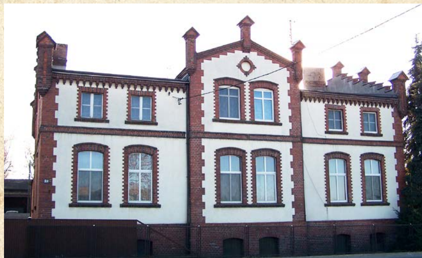
☛ Łowęcin. Dom Frąckowiaków wybudowany ok. 1900 r., potem należący do Krychów, a obecnie własność rodziny Molińskich, stan w 2015 r. (fot. Antoni Kobza).
