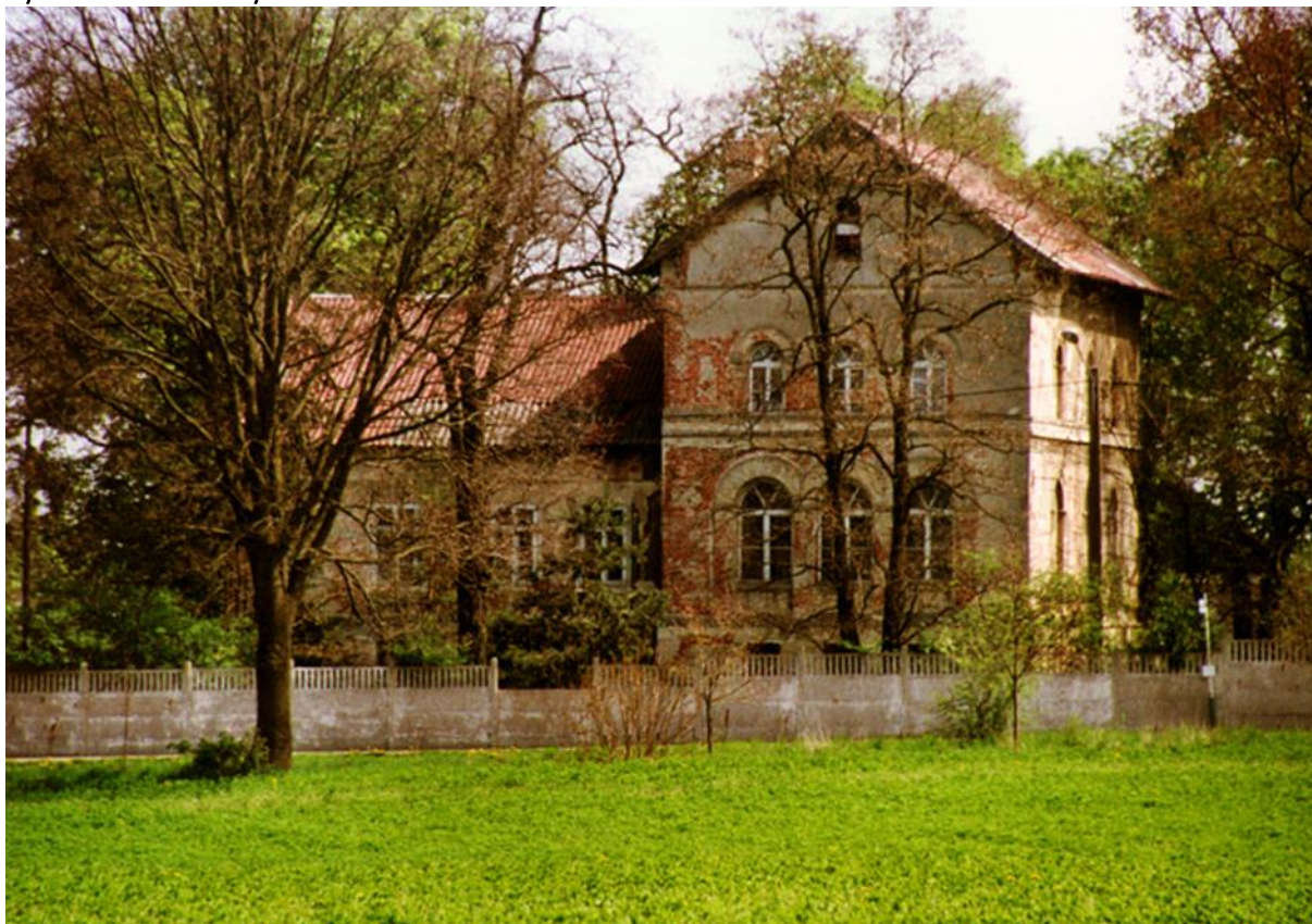
Rycina 8. Zniszczony dwór w Karłowicach
