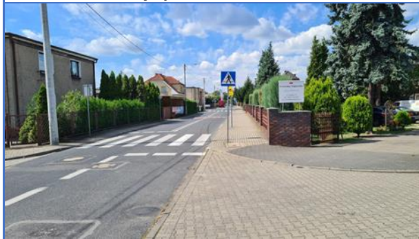
Stan infrastruktury drogowej na skrzyżowaniu ulic Sienkiewicza i Krętej
