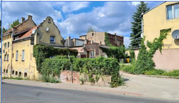
Zdegradowana zabudowa w rejonie ulicy Strzeleckiej
