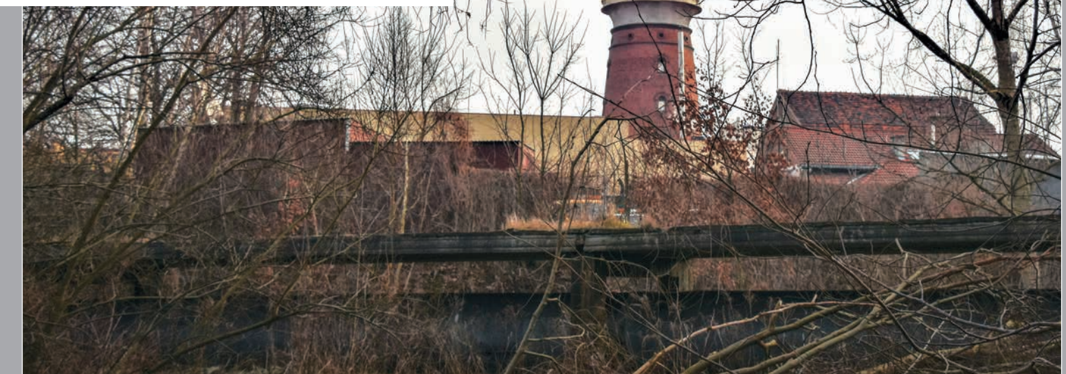
▲ ▲ WIEŻA CIŚNIEŃ, RZEŻNIA, GAZOWNIA, OK. 1940 R.
