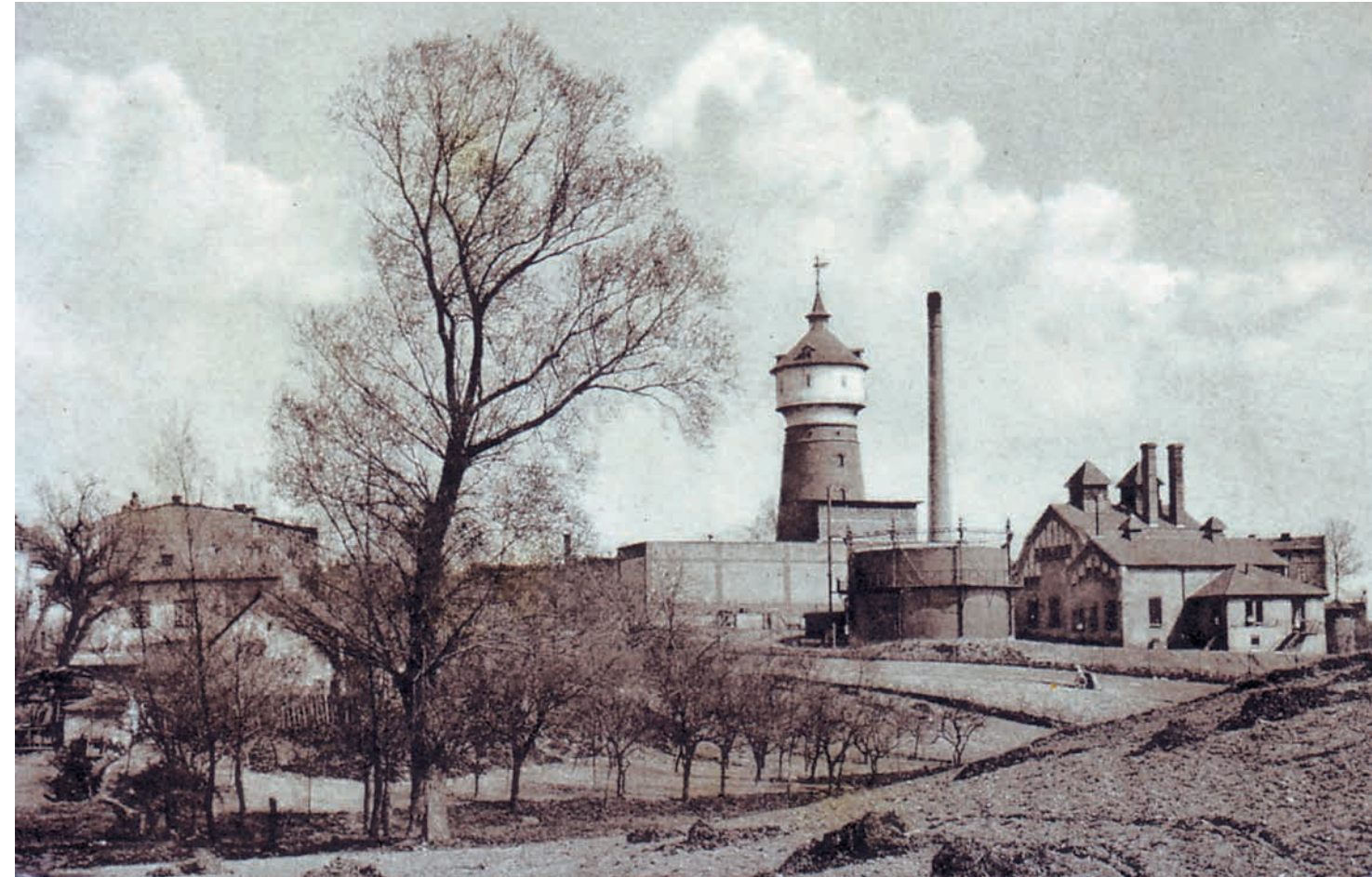
▲ WIEŻA CIŚNIEŃ, RZEŻNIA, GAZOWNIA, OK. 1914 R.
