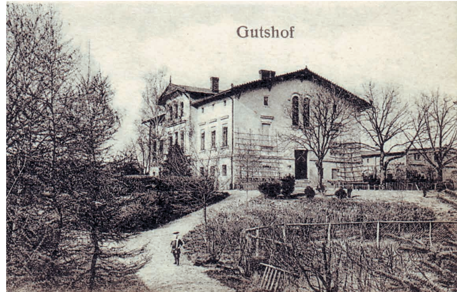
▲ DWÓR HOFFMEYERÓW PRZY ULICY ZAMKOWEJ, OK. 1910 R.
