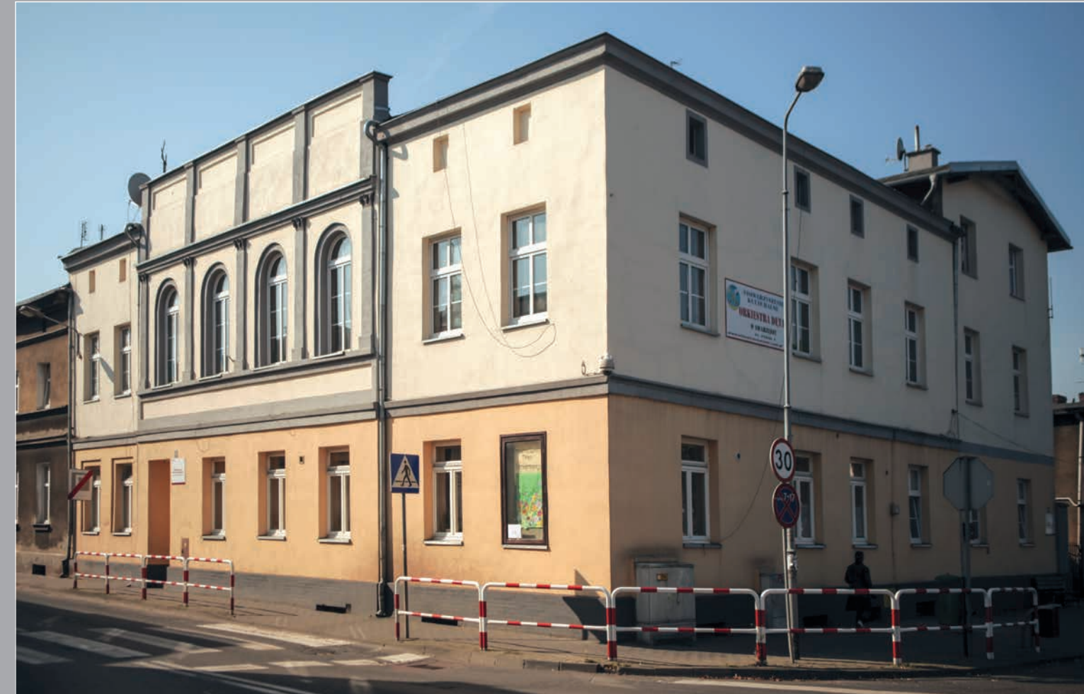
▲ BUDYNEK PRZY NAROŻNIKU ULICY PIASKI I PLACU NIEZŁOMNYCH (SIEDZIBA SWARZĘDZKIEJ ORKIESTRY DĘTEJ ORAZ ŚRODOWISKOWEGO DOMU SAMOPOMOCY OŚRODKA POMOCY SPOŁECZNEJ W SWARZĘDZU), 2017 R., fot. R. Błachnio
