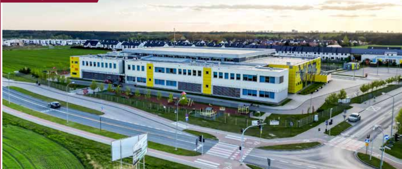
Budowa Szkoły Podstawowej nr 2
