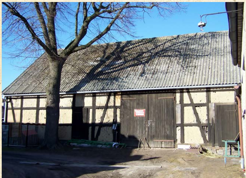
Stodoła z XIX wieku budowana w technice szachulcowej. (fot. Antoni Kobza)
