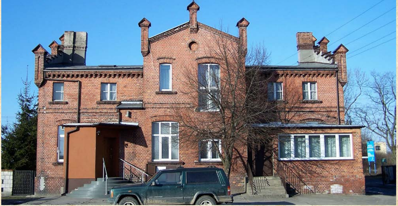
Łowęcin. Dom Kazimierza Krycha, zbudowany w 1900 r., widok od podwórza, obecnie własność rodziny Molińskich. (fot. Antoni Kobza).
